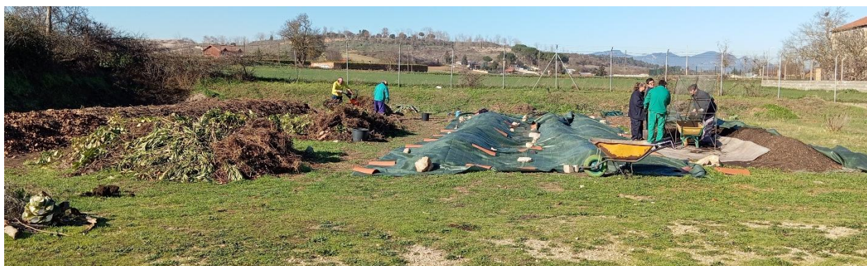
Ilustración 7. Ejemplo de planta de gestión de restos vegetales y biorresiduos de grandes generadores (ASPODEMI)
